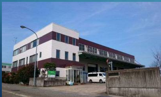
第2工場 (製造部)
