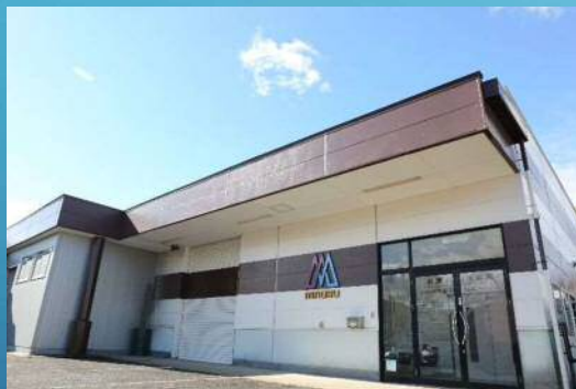
第1工場 (製造部)
